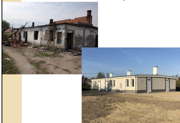
Barakk lakások felújítása
